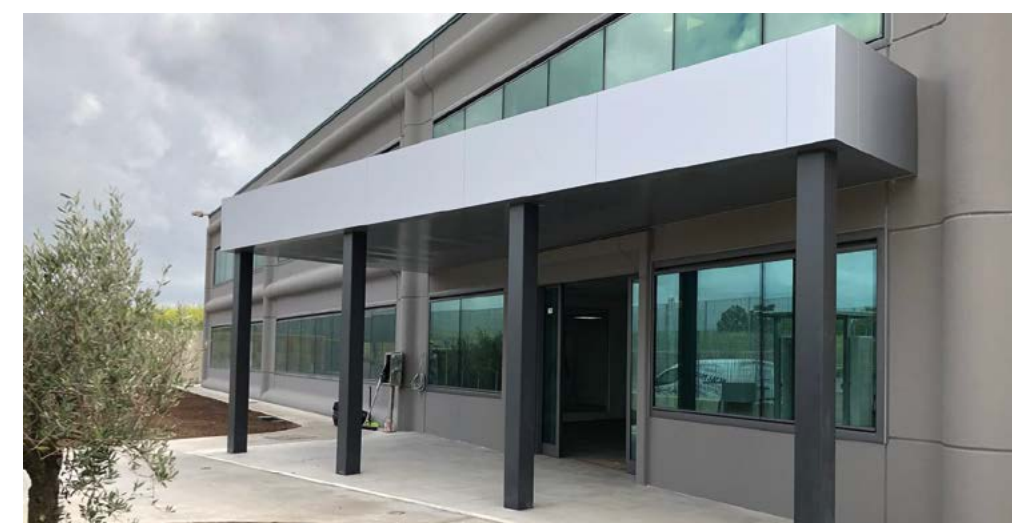
L'azienda di Pomezia fornisce non solo il prodotto, ma cura anche l'installazione in cantiere in modo da ella di fornire ai propri clienti un servizio di qualità totale.
